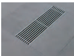
Воздухораспределители и перфорированные панели
