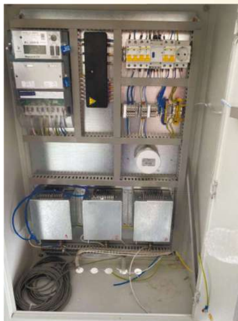
Рис. 4 Блоки ИПН-05 в навесном щите со счетчиком Меркурий 234
