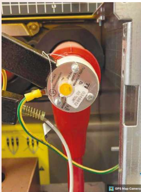
Рис. 3 Подключение ИПЭЛ 10-188-04И в кабельный адаптер КРУЭ 10 кВ
